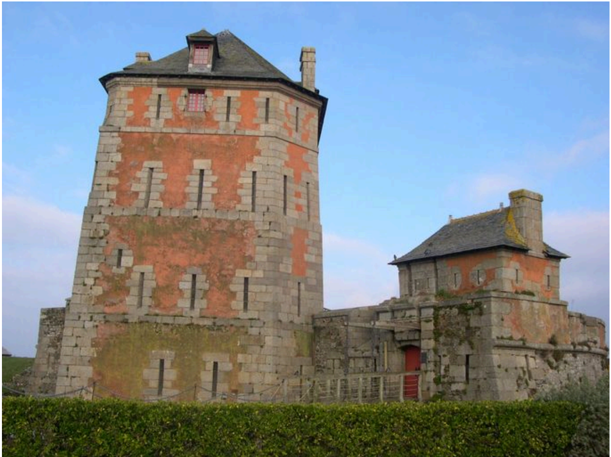
Face sud de la Tour Vauban avant restauration
