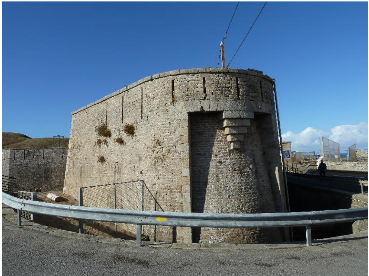
Saint-Pierre-Quiberon, fort de Penthievre, enceinte, orillon de la branche nord-est.
