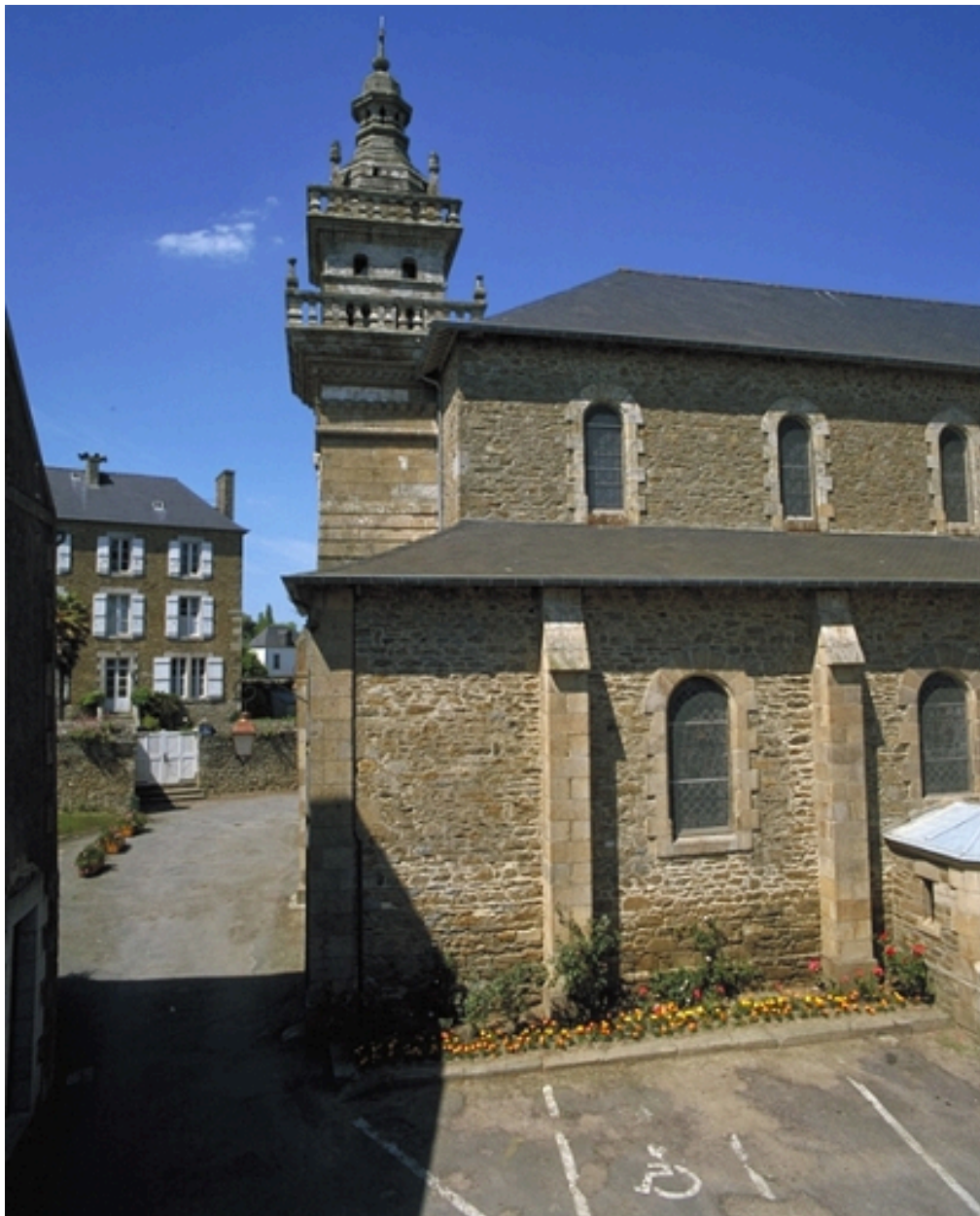
Vue générale sud-ouest ; le presbytère au deuxième plan
