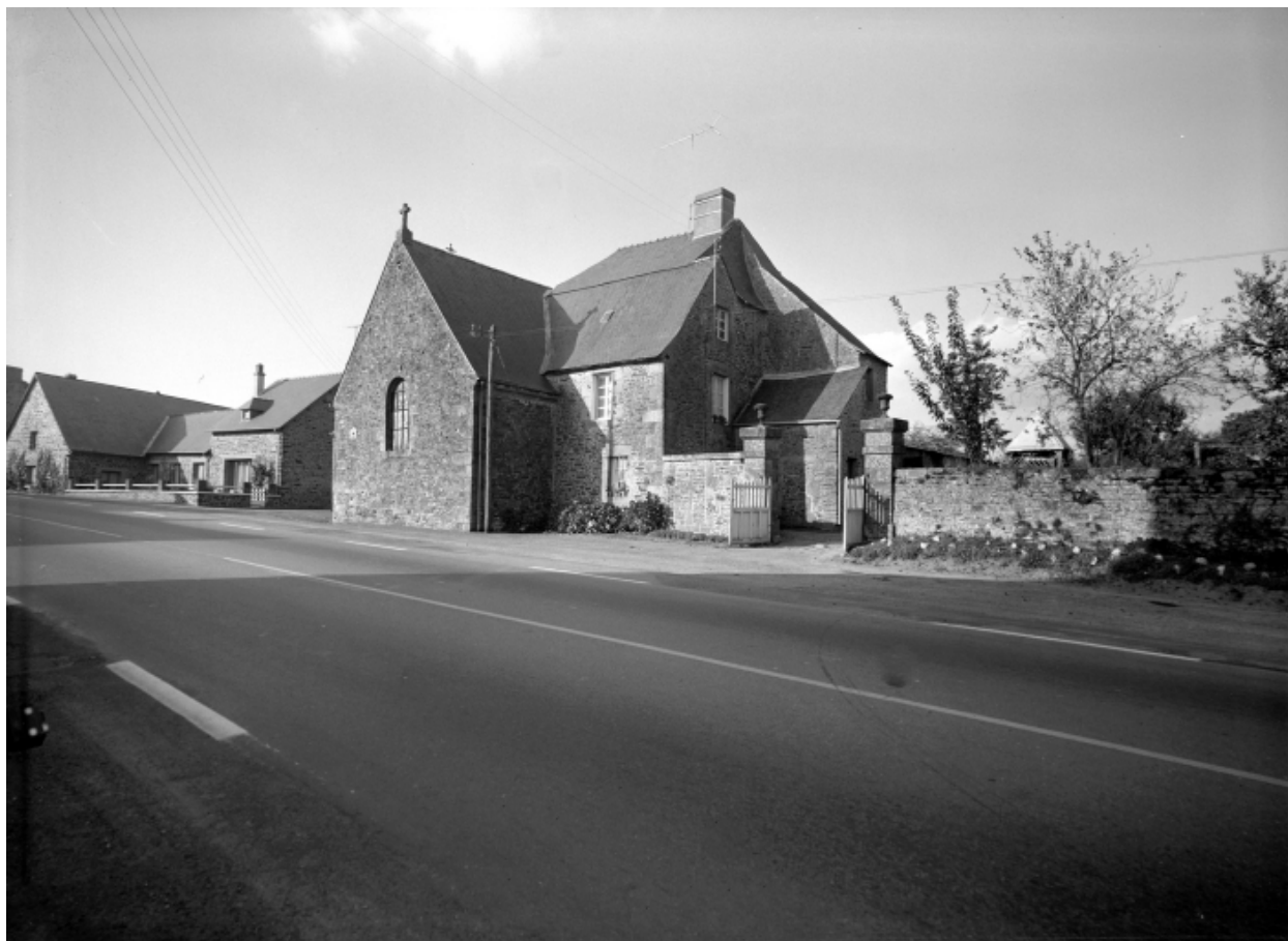
Elévation sud-est : vue générale
