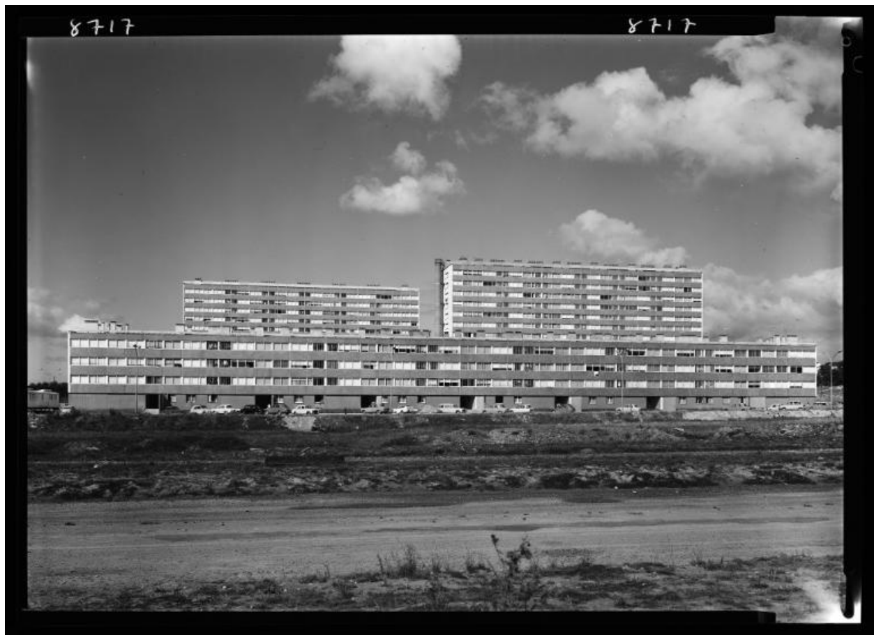
Vue d'ensemble depuis l'est. 7 septembre 1964.
