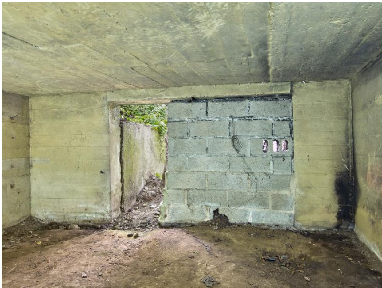
Vue de l'entrée (partiellement murée par des parpaings) de la chambre de tir. Le sol du bunker a été remblayé
