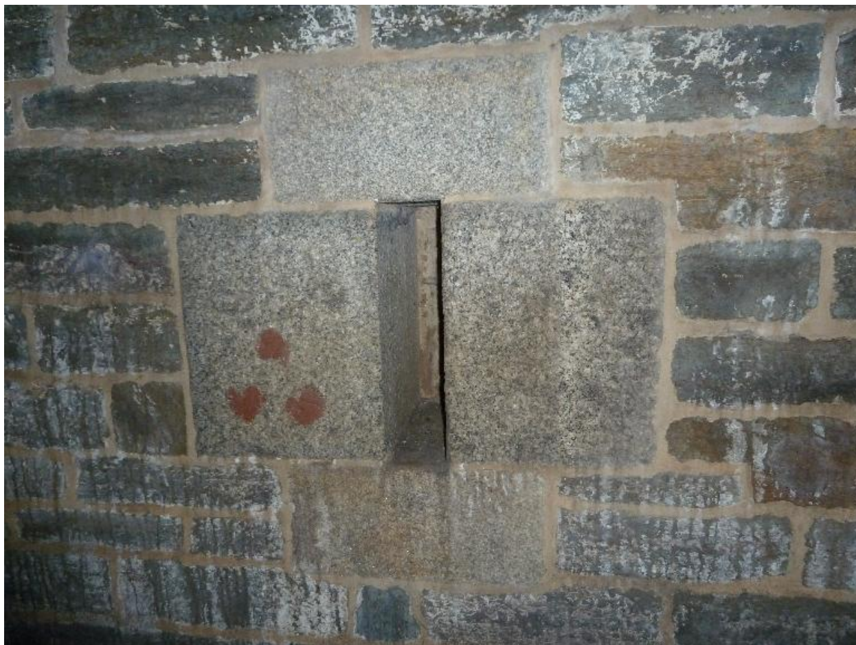
Groix, batterie du Bas-Grognon, corps de garde crénelé, évent d'un magasin à poudre.
