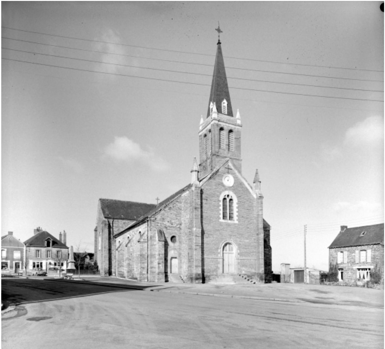
Elévation Nord-Ouest : vue générale
