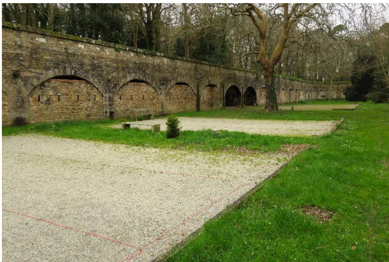
Le Palais, enceinte urbaine, galerie de contrescarpe, casemates face à la courtine 20-21.
