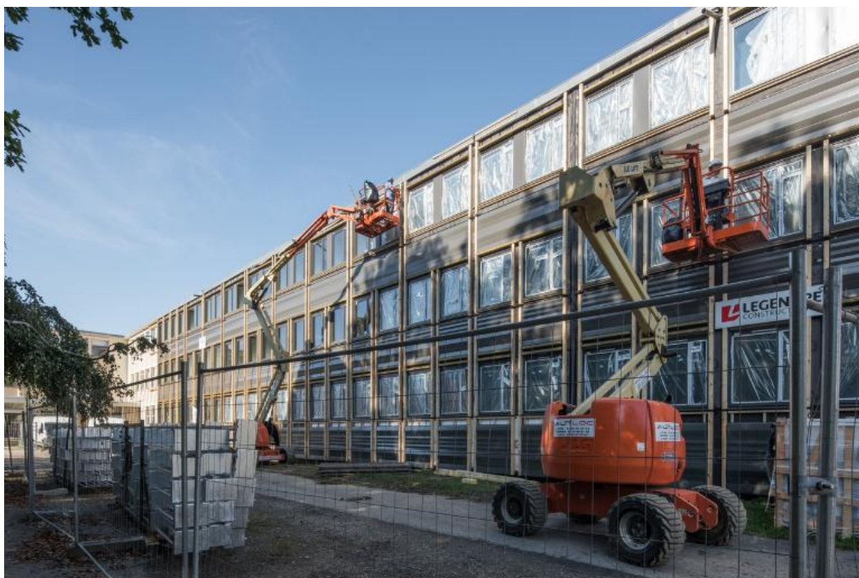
Bâtiment C (externat) , façade sud : travaux de réhabilitation thermique.
