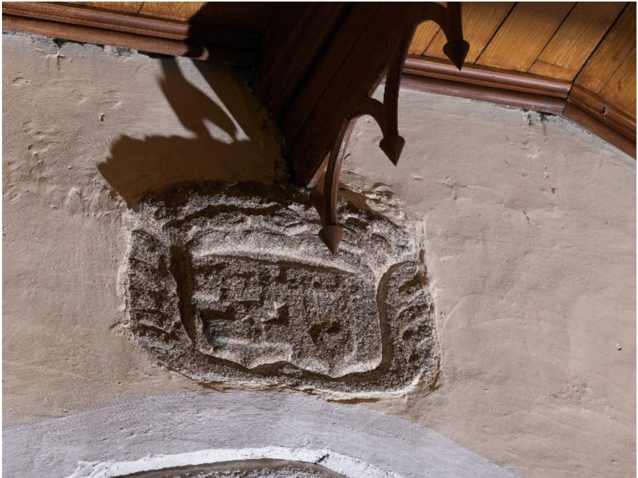
Blason de la voute haute du choeur
