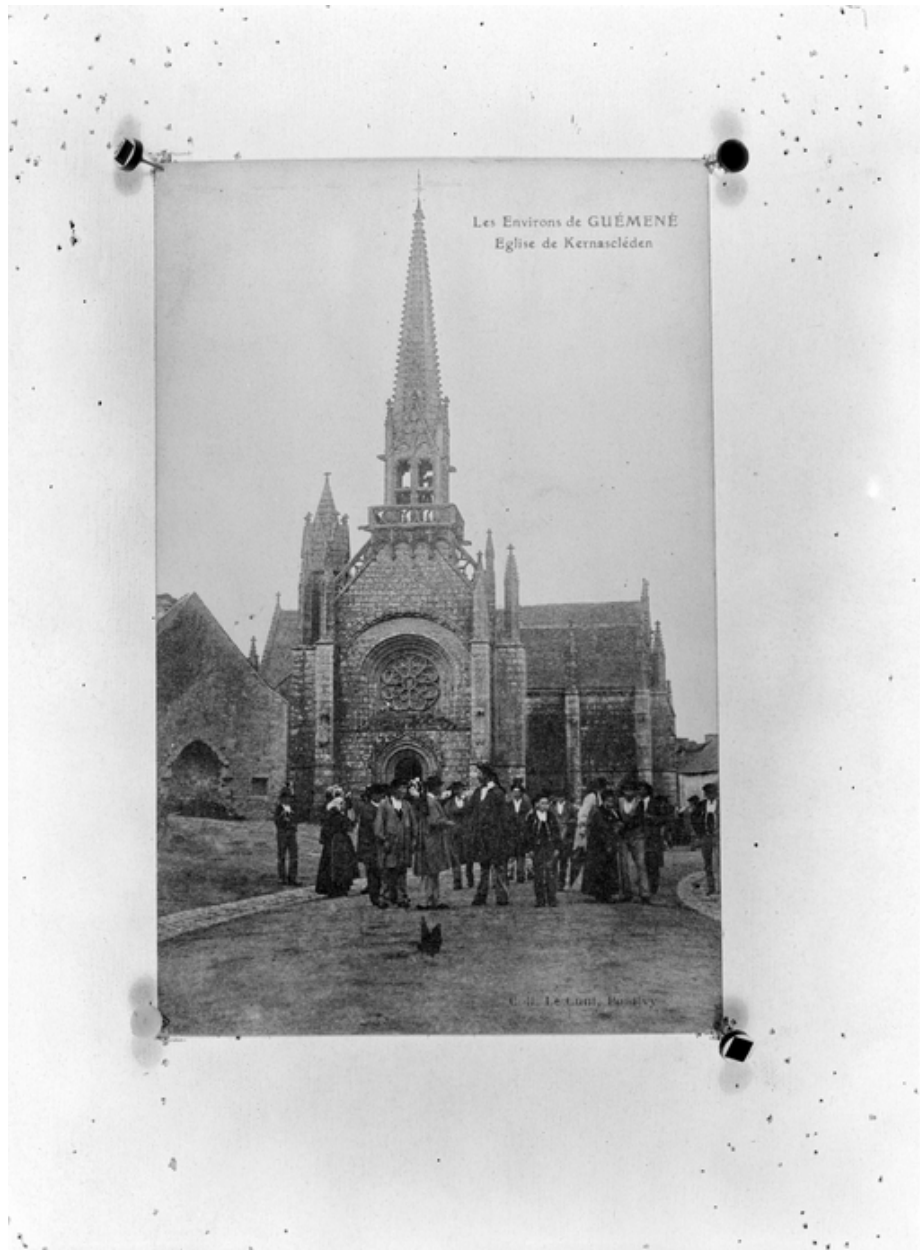
Façade ouest, vue générale (reproduction AD, 56, 213-3).
