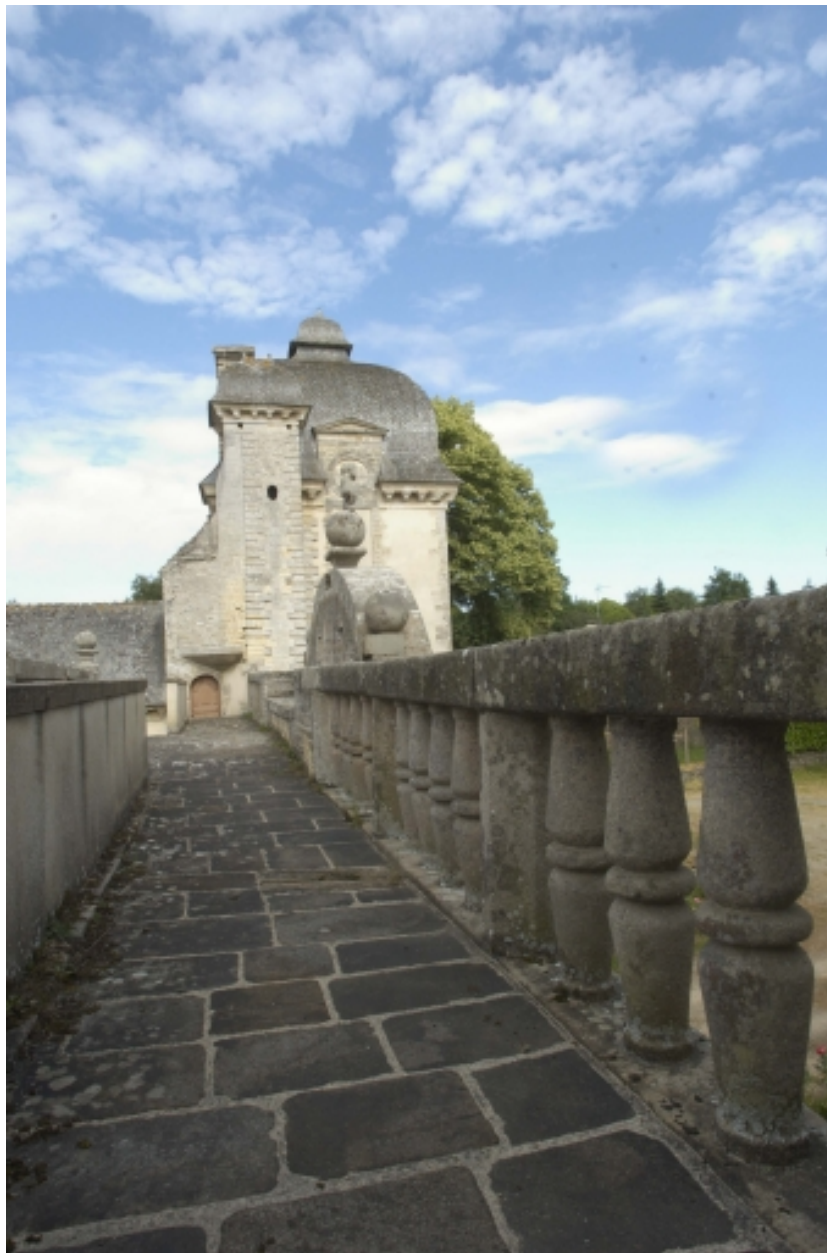
Corps de passage, partie supérieure accédant au pavillon d'angle
