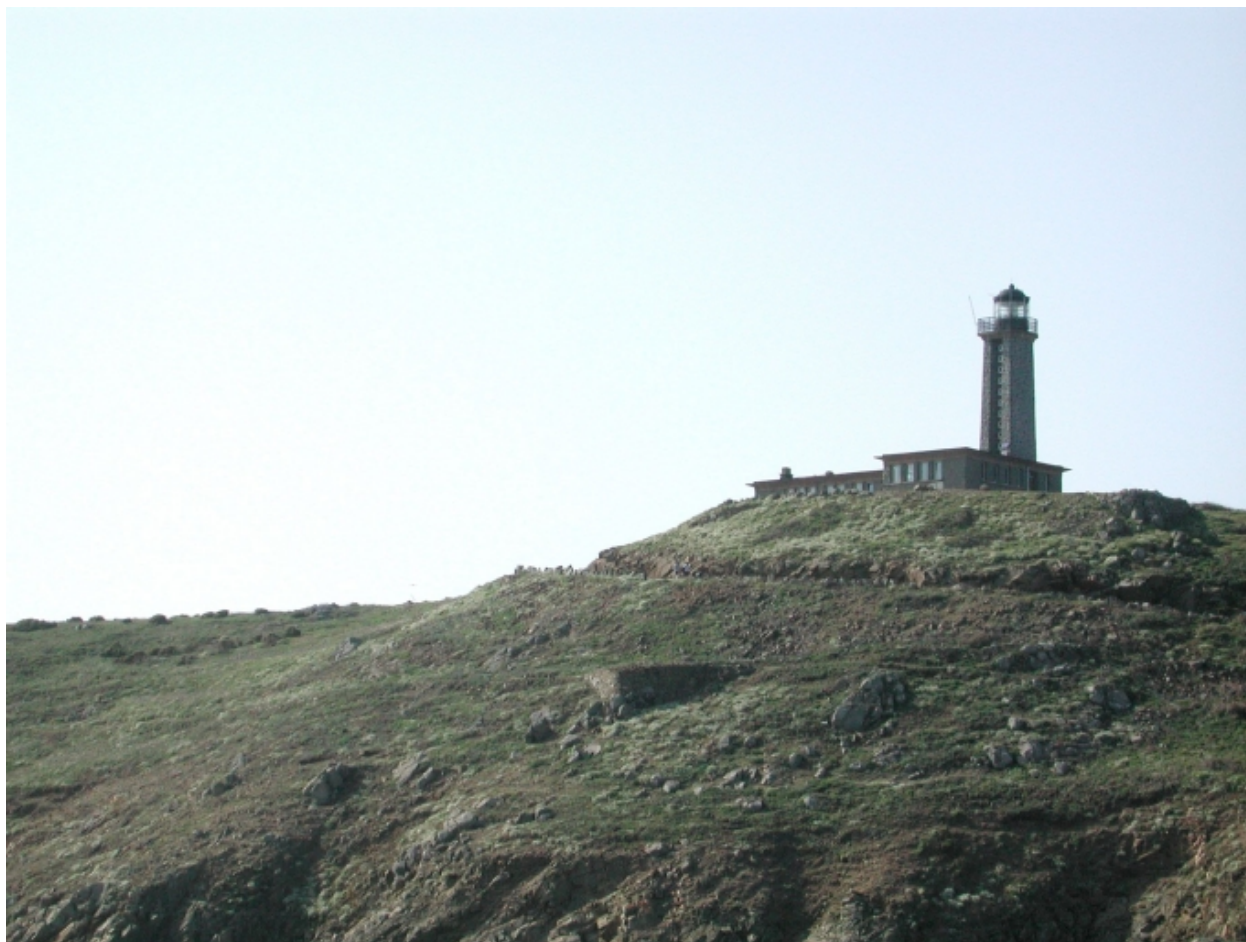
Vue générale : façade sud
