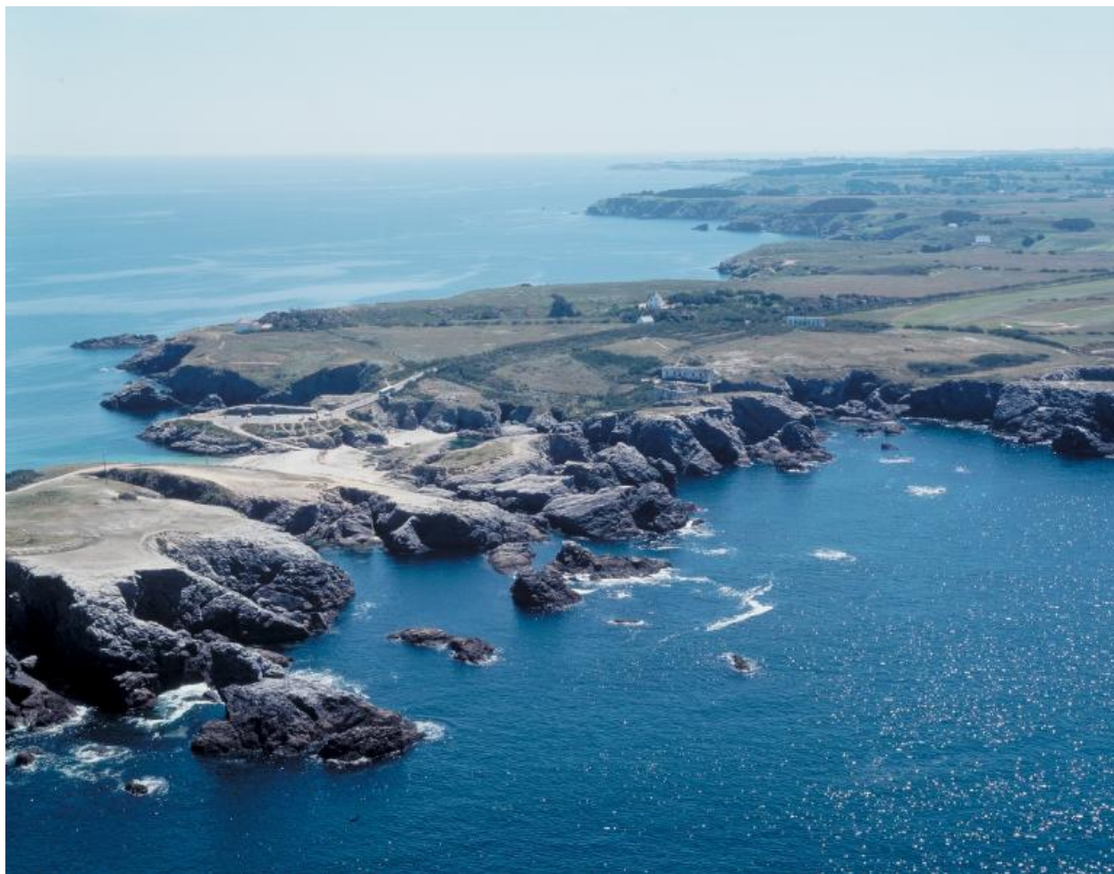
Vue aérienne générale du réduit, prise du sud-ouest.
