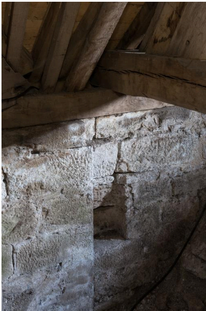
Vue de détail : vestige d'empochement en partie haute du mur ouest du croisillon nord.
