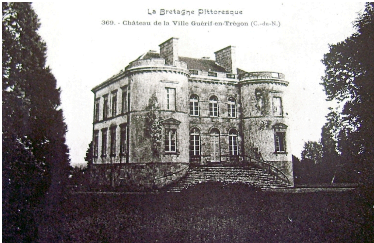
Vue générale, façade antérieure (AD 22)
