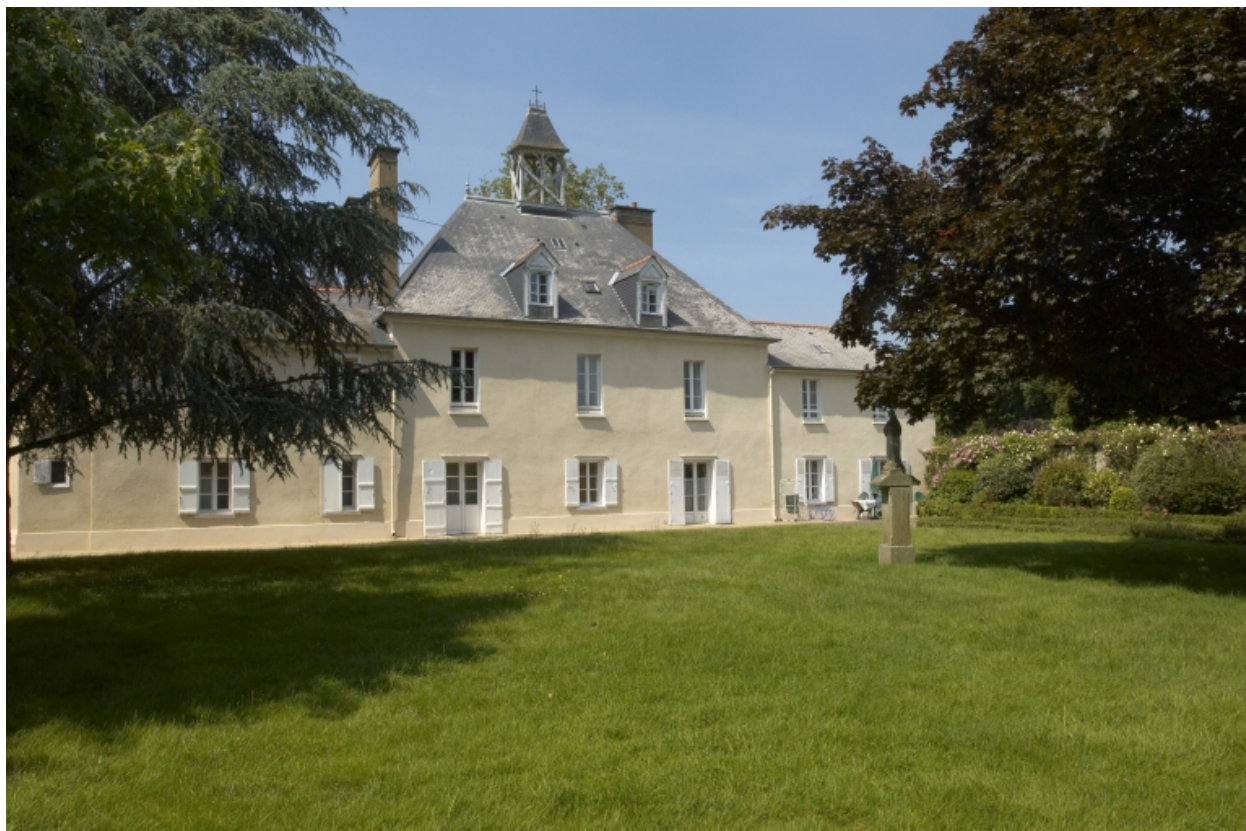
Vue générale postérieure
