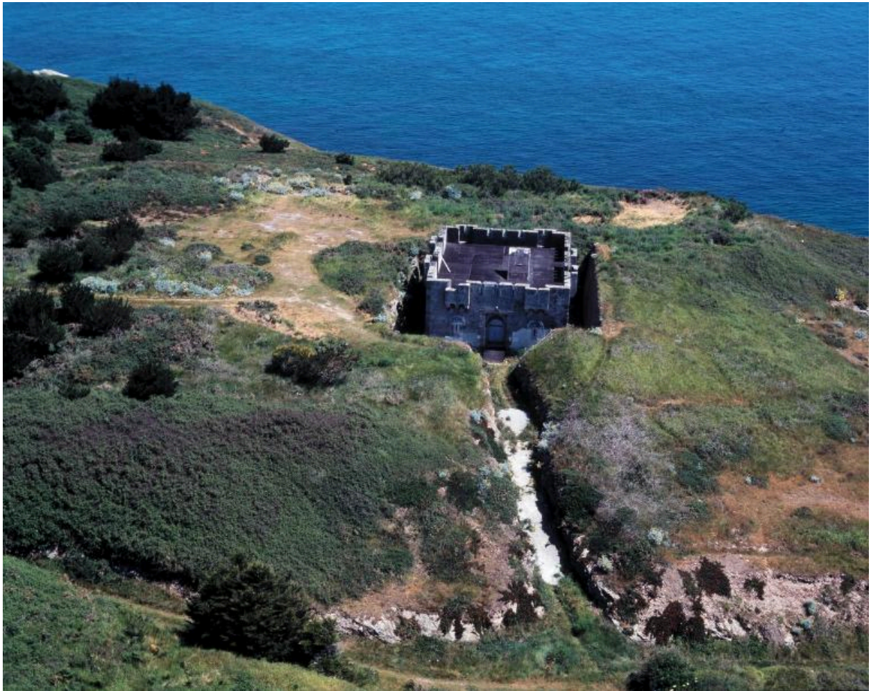
Locmaria, batterie de Kerdonis, corps de garde crénelé, vue aérienne.
