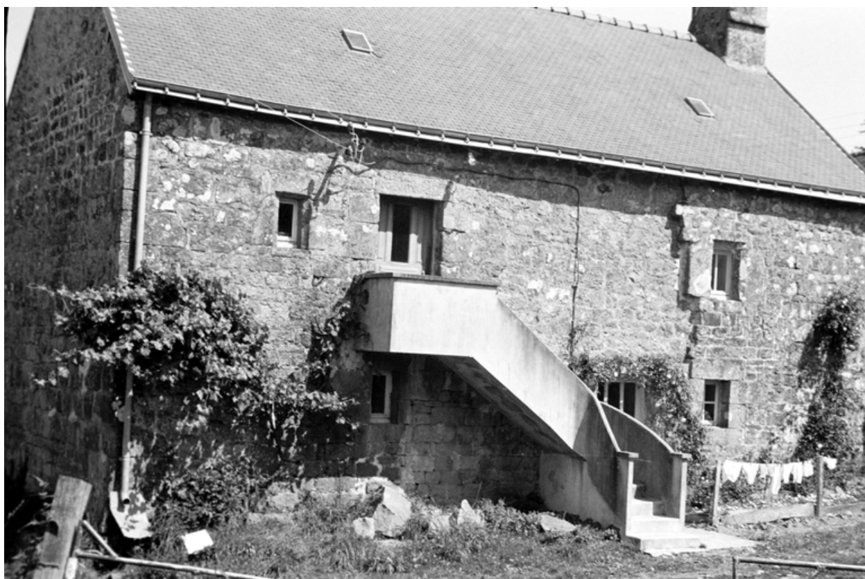
Botcanou (maison 5) : élévation sud
