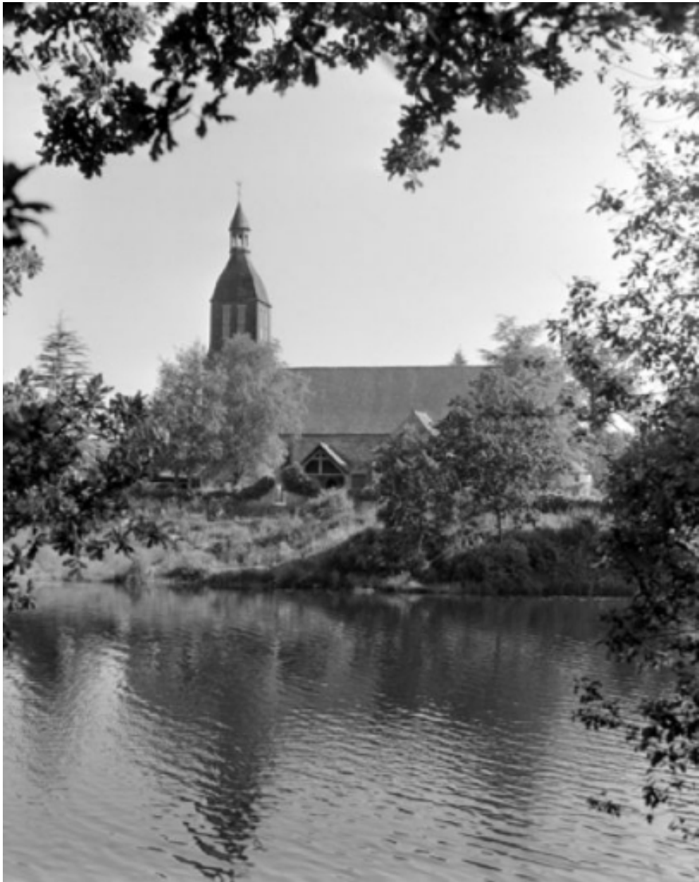
Elévation sud, partie ouest : vue générale
