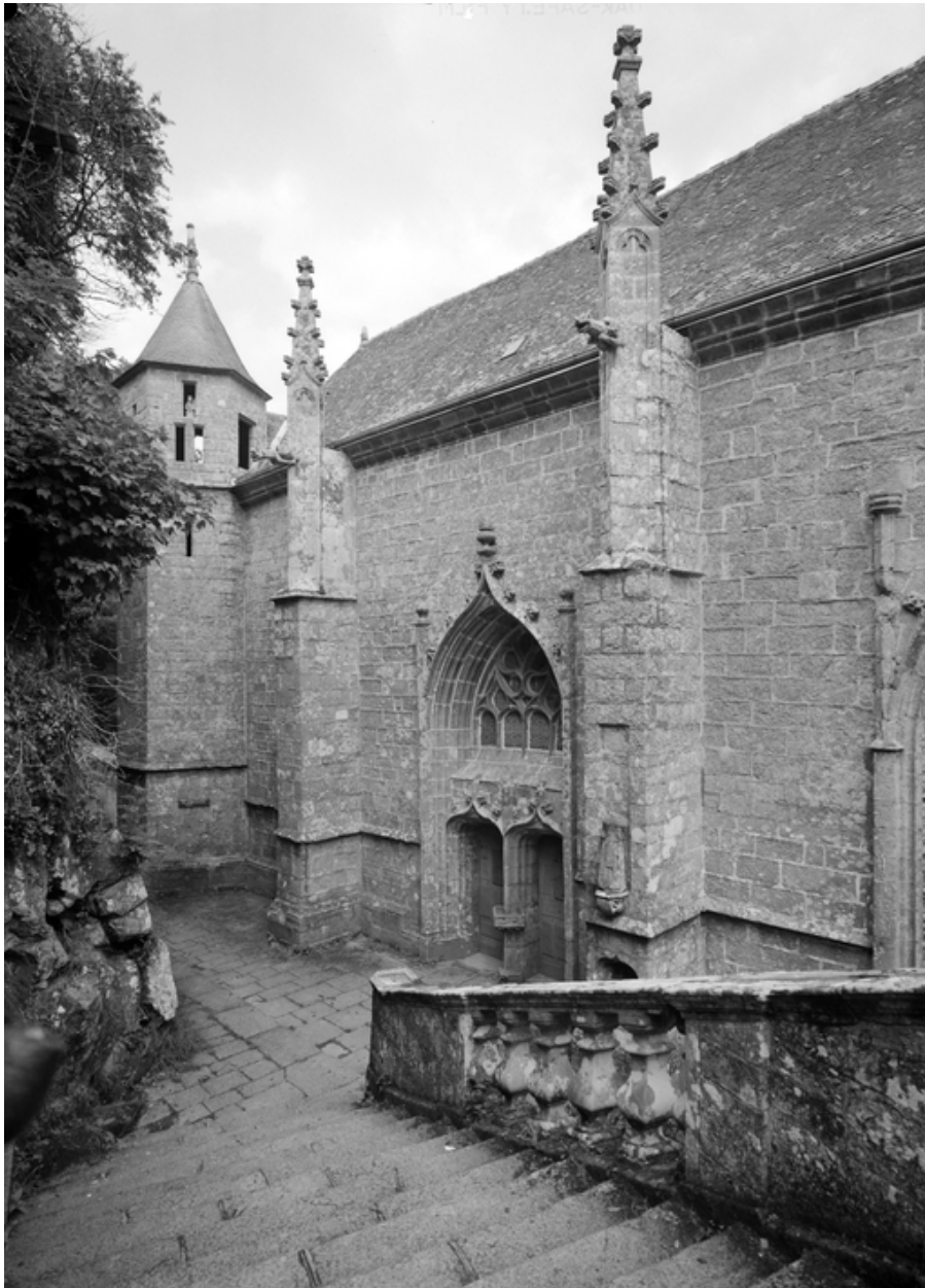
Façade ouest, vue générale.
