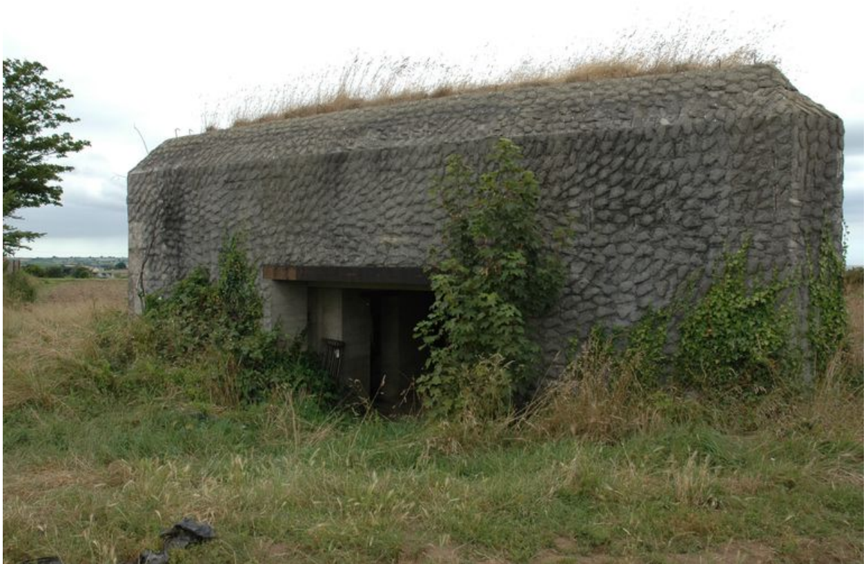
Vue du bunker-casemate nord côté entrée (état en 2008)
