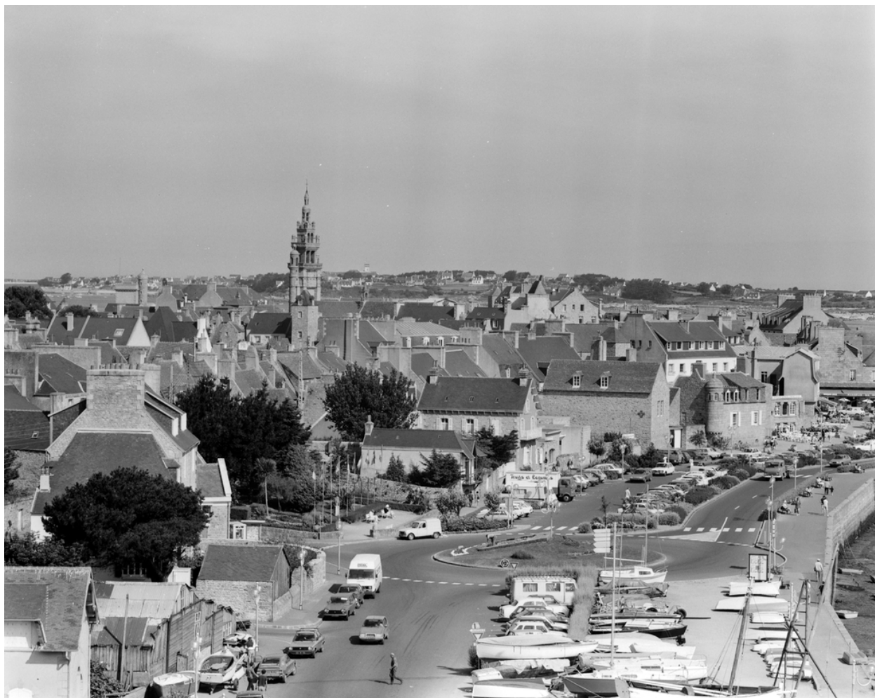
Quai Charles de Gaulle, vue générale
