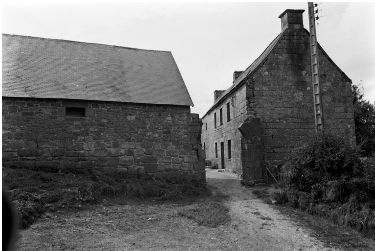
Vue générale de l'entrée est
