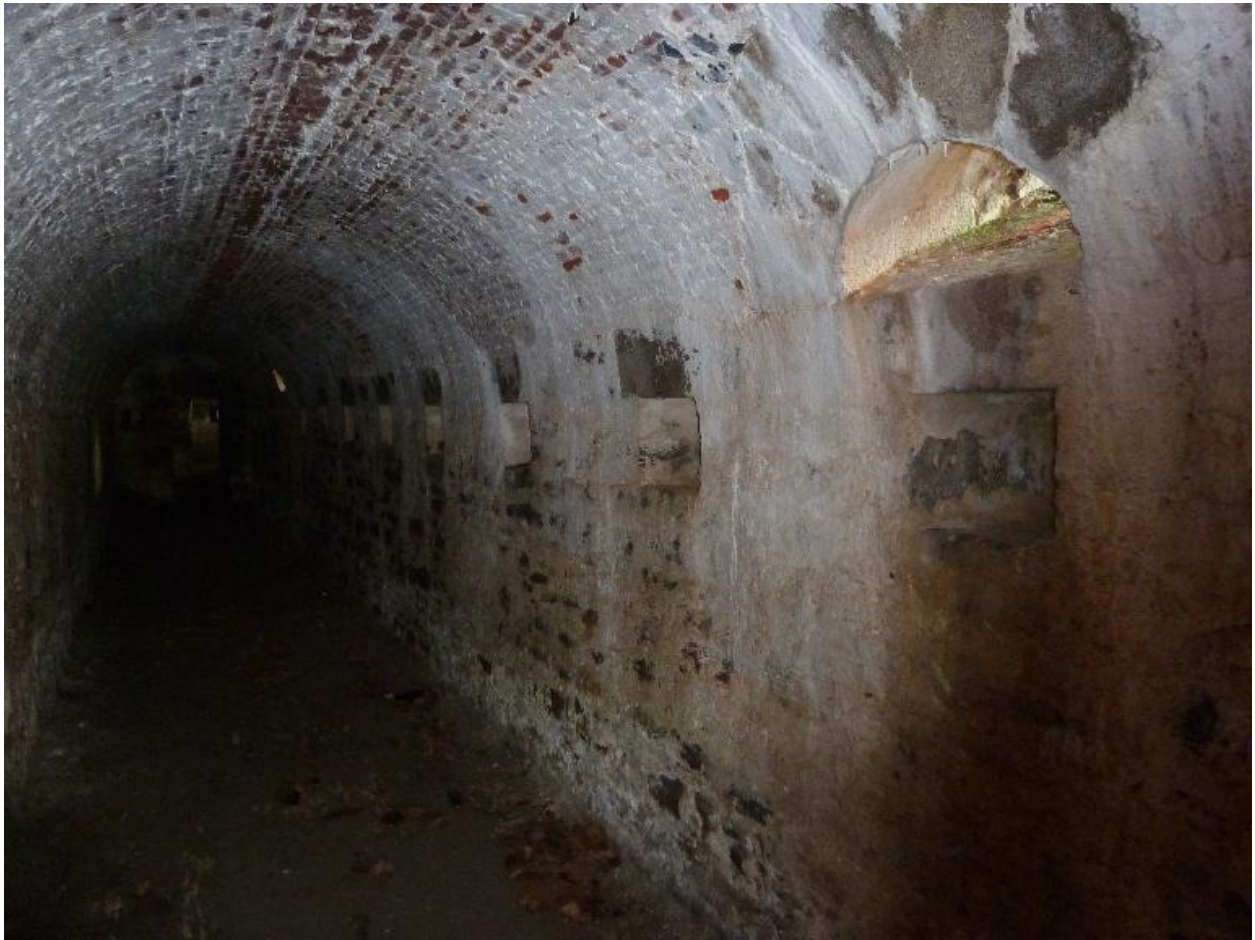
Le Palais, enceinte urbaine, galerie de contrescarpe, casemate des extrémités.
