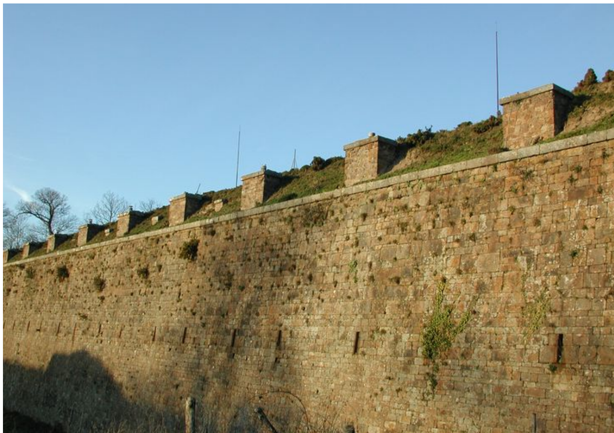
Elévation Sud : détail de la courtine. Noter les créneaux de fusillade
