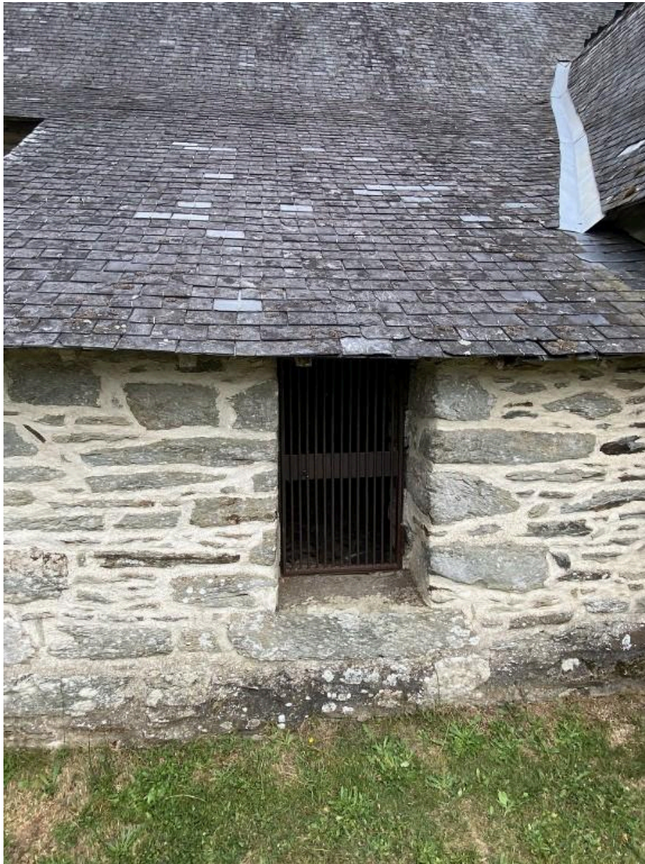
Élévation sud, détail
