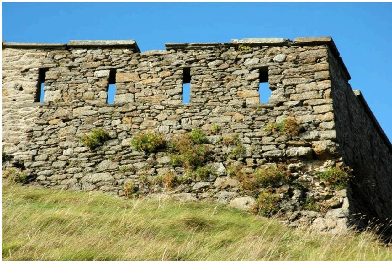
Elévation Sud : détail des créneaux de fusillade
