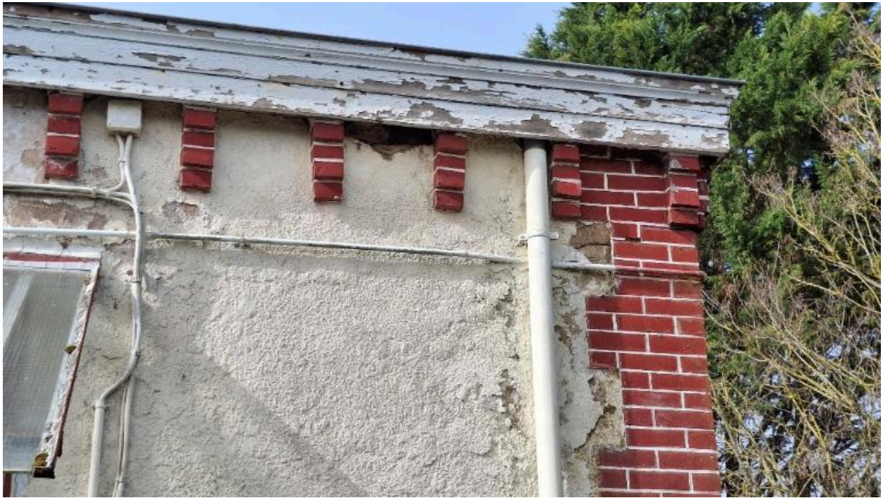
Maison éclusière, détail des maçonneries
