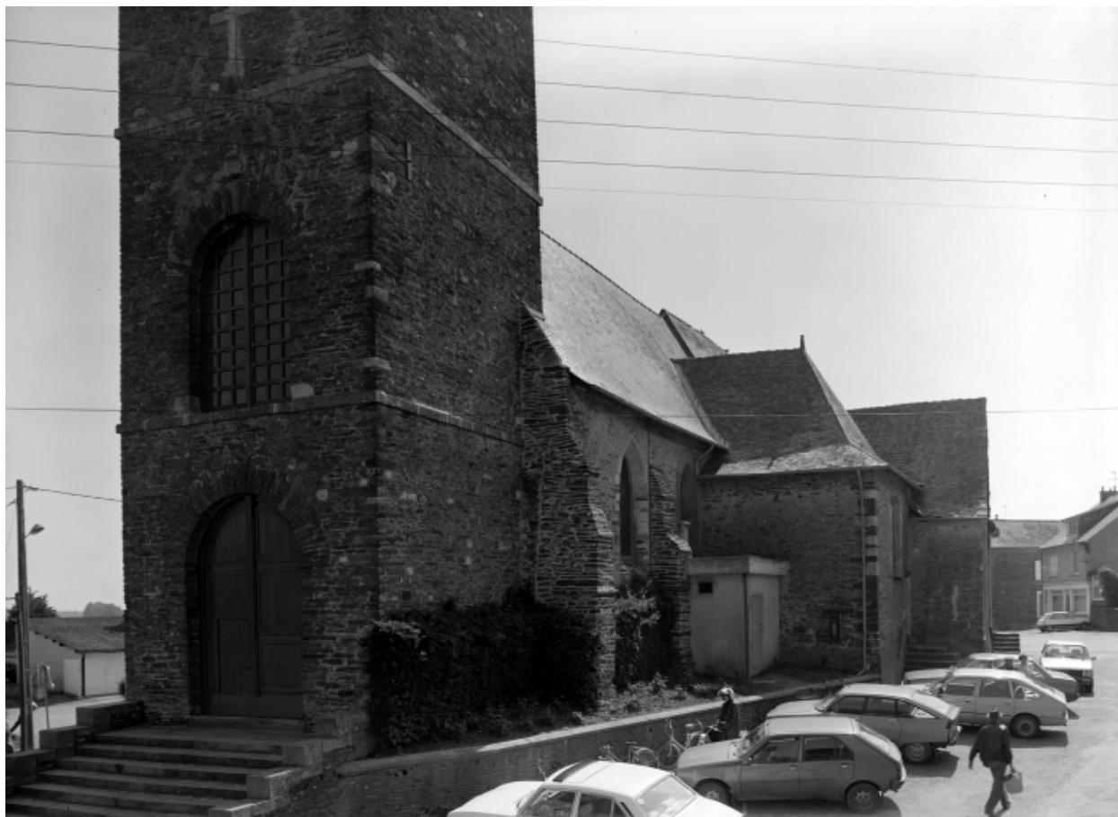
Elévation Sud-Ouest : vue générale
