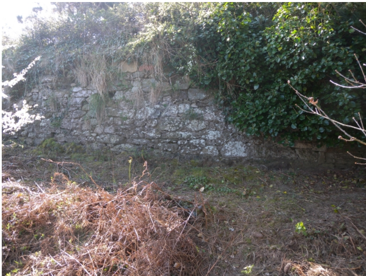
Vue du mur extérieur du parapet
