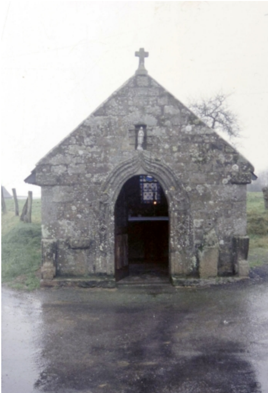
Elévation ouest : vue générale.
