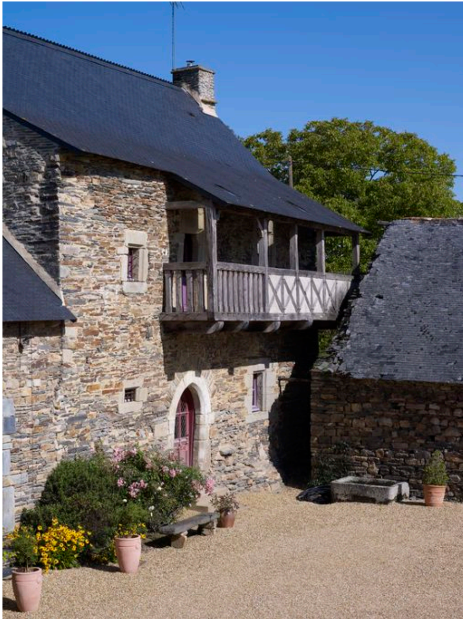
Manoir : vue générale prise du sud-ouest (état en 2011)
