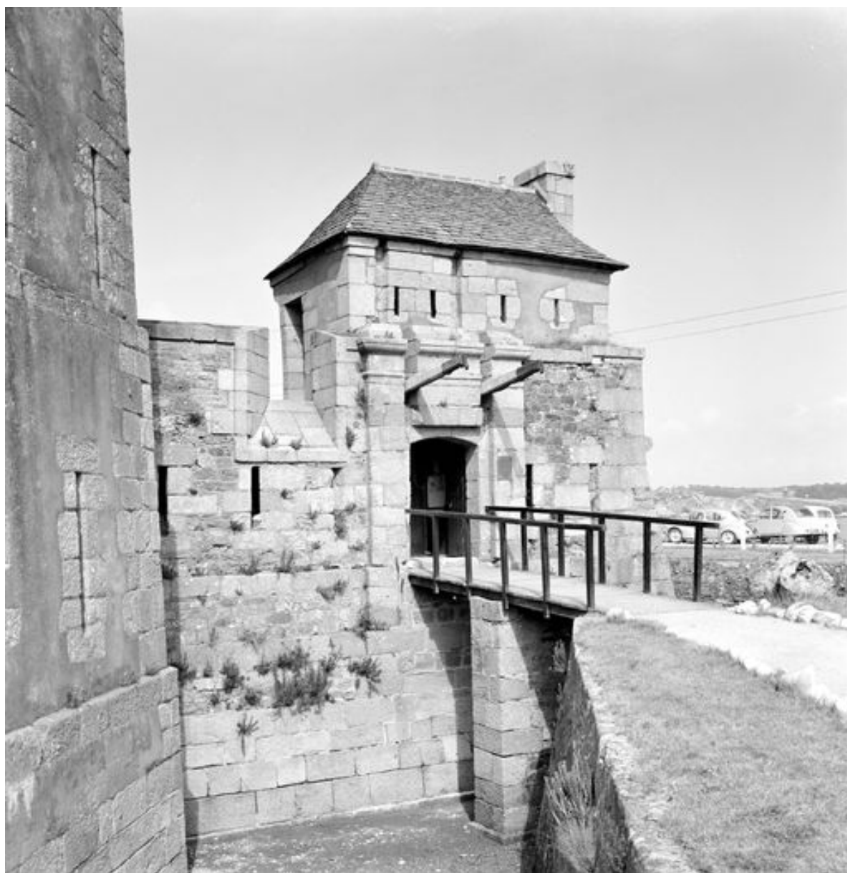
Vue du dispositif d'entrée de la Tour Vauban en 1969
