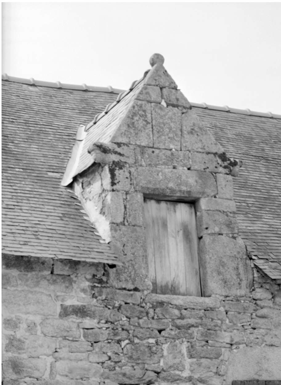
Communs, détail d'une lucarne.
