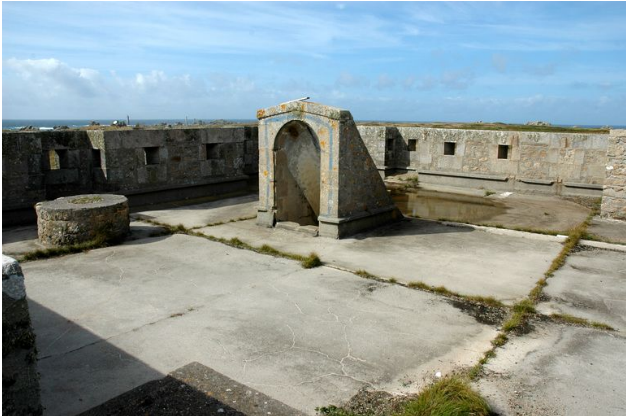
Vue du réduit de batterie de côte de Loqueltas. La terrasse est dotée de huit bretèches et créneaux de fusillade. En arrière-plan : la pointe de Pern
