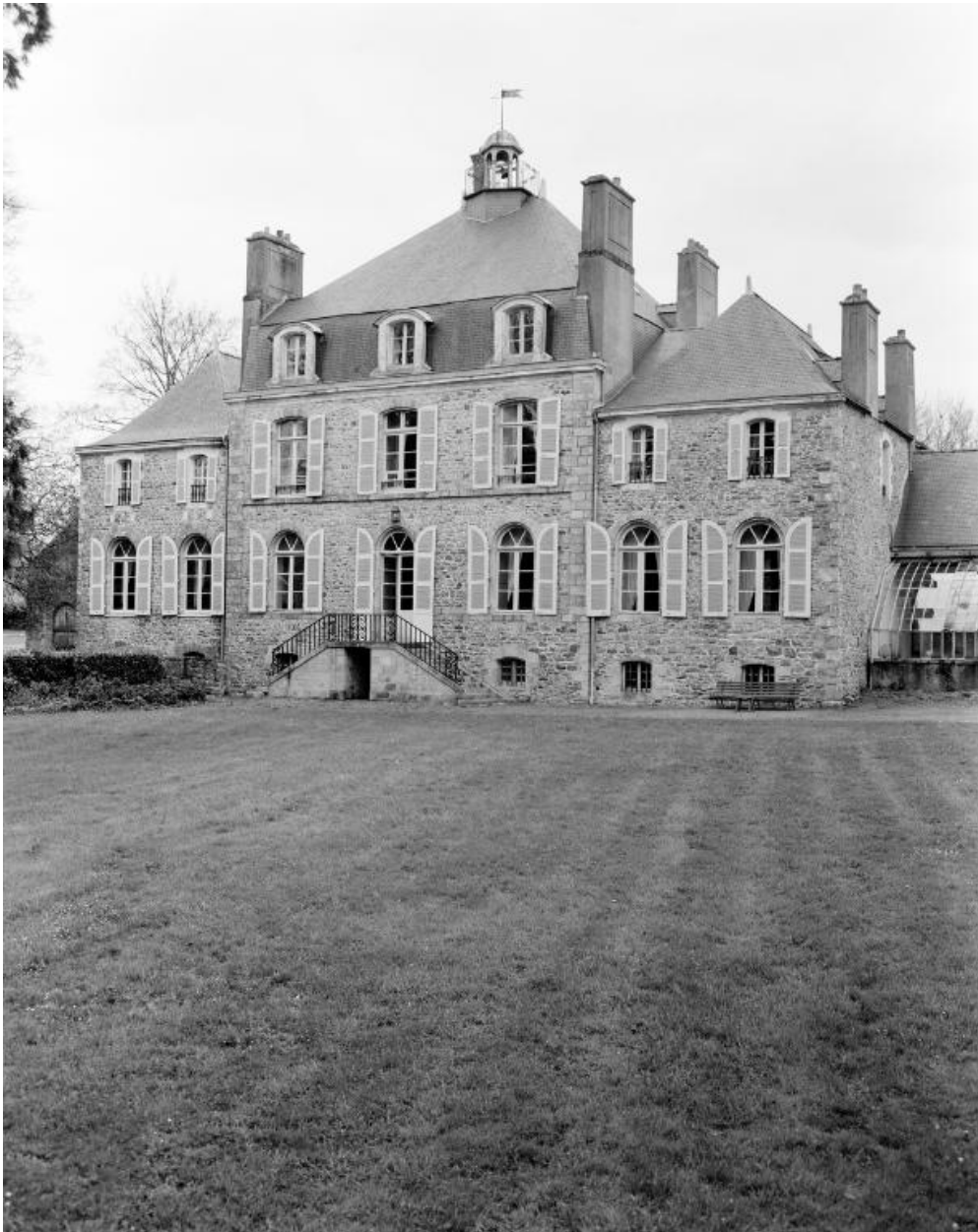
Elévation sud, vue générale.
