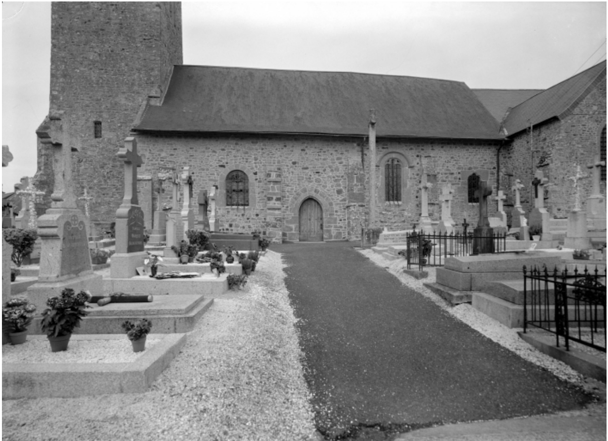
Elévation sud, partie centrale : vue générale
