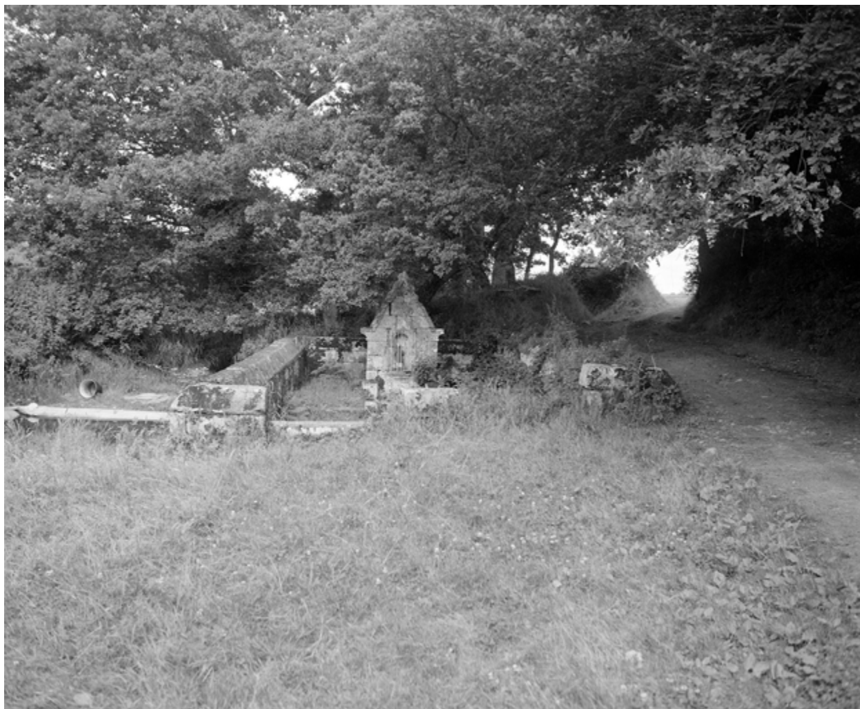
Vue générale de la fontaine
