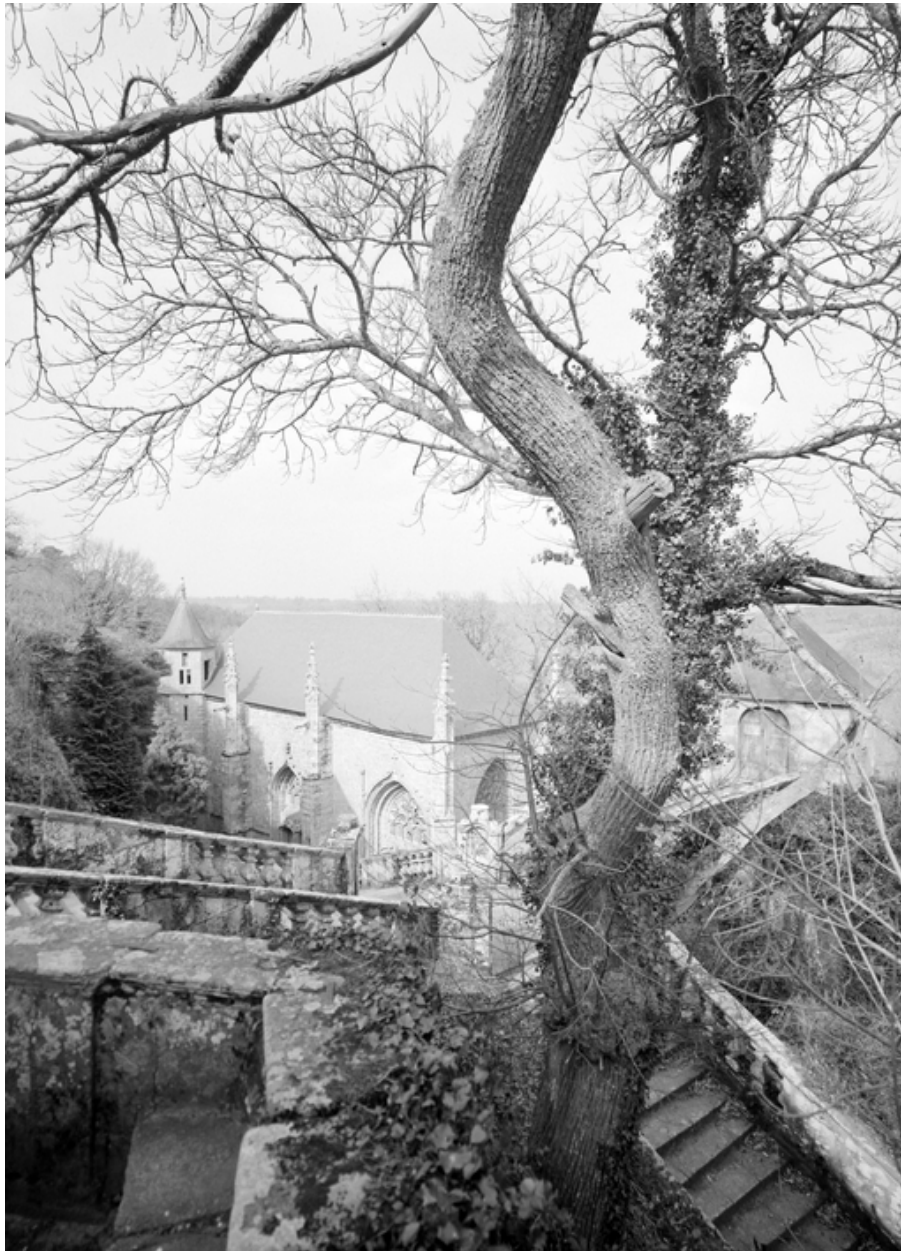
Vue générale prise du sud.
