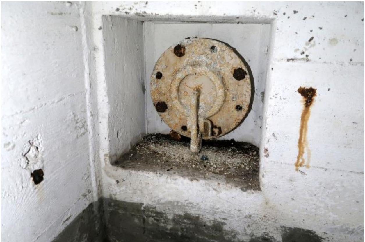
Vue de l'entrée nord : extrémité nord du couloir avec bouche de surpression à clapet à contrepoids en aluminium
