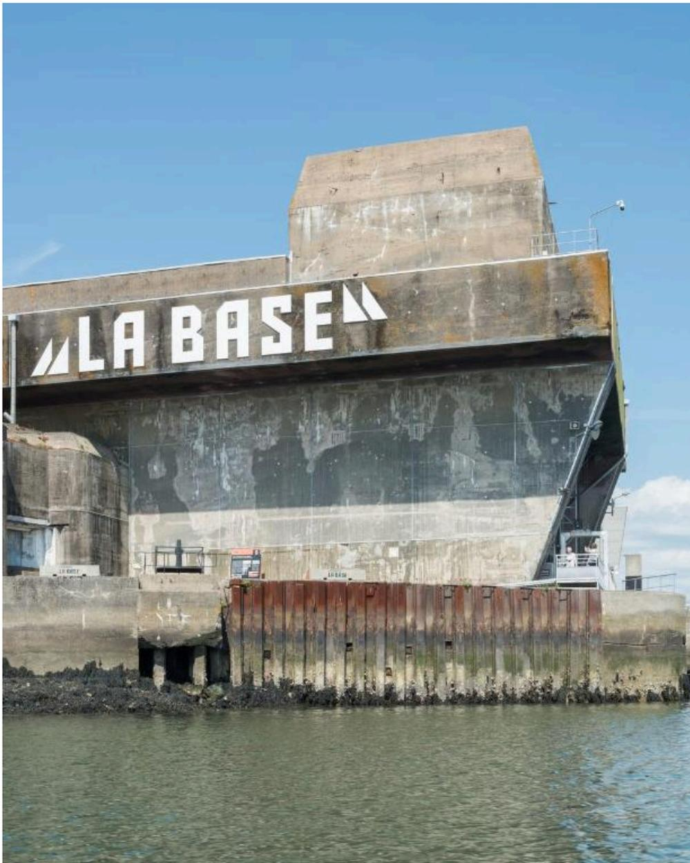
Vue de l'entrée du slipway, élévation ouest. Le bunker "KI" est surmonté d'un envuvement pour un canon antiaérien. A gauche, embrasure de la casemate de flanquement
