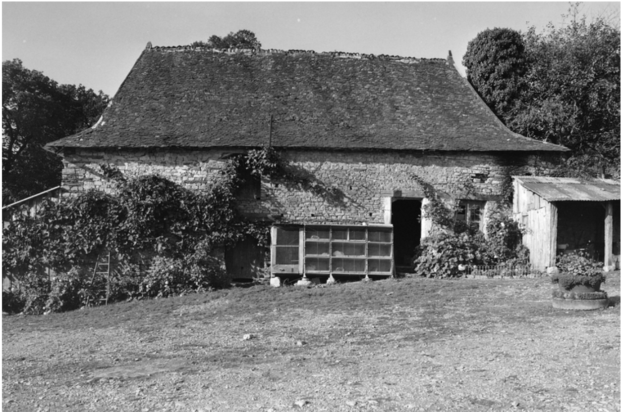
Dépendances de la ferme, bâtiment ouest, vue générale.
