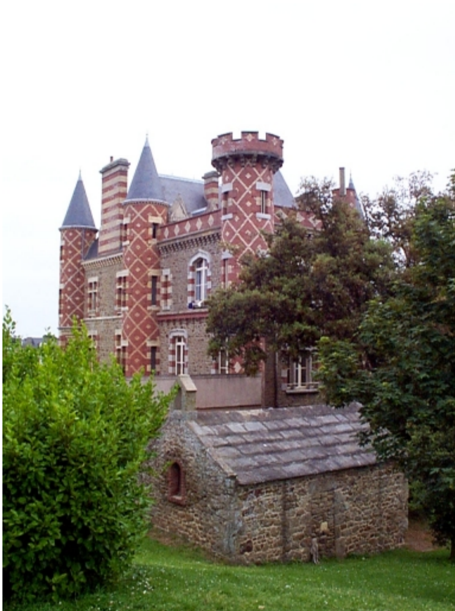
La chapelle : vue de situation sud
