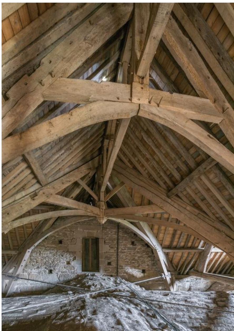
Vue de la charpente du choeur et de la croisée du transept depuis l'est.
