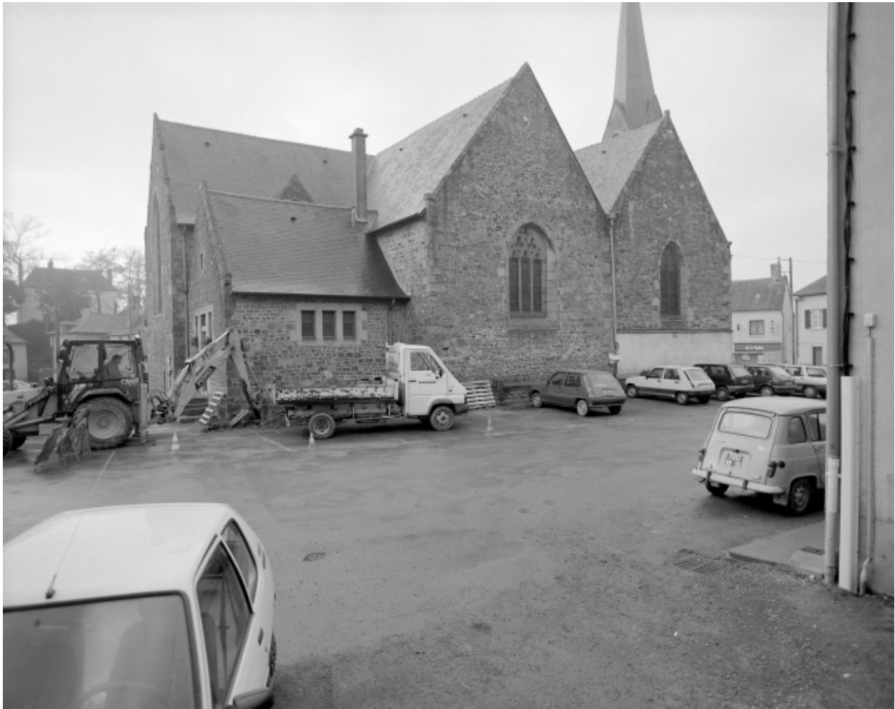
Elévation nord-est : vue générale
