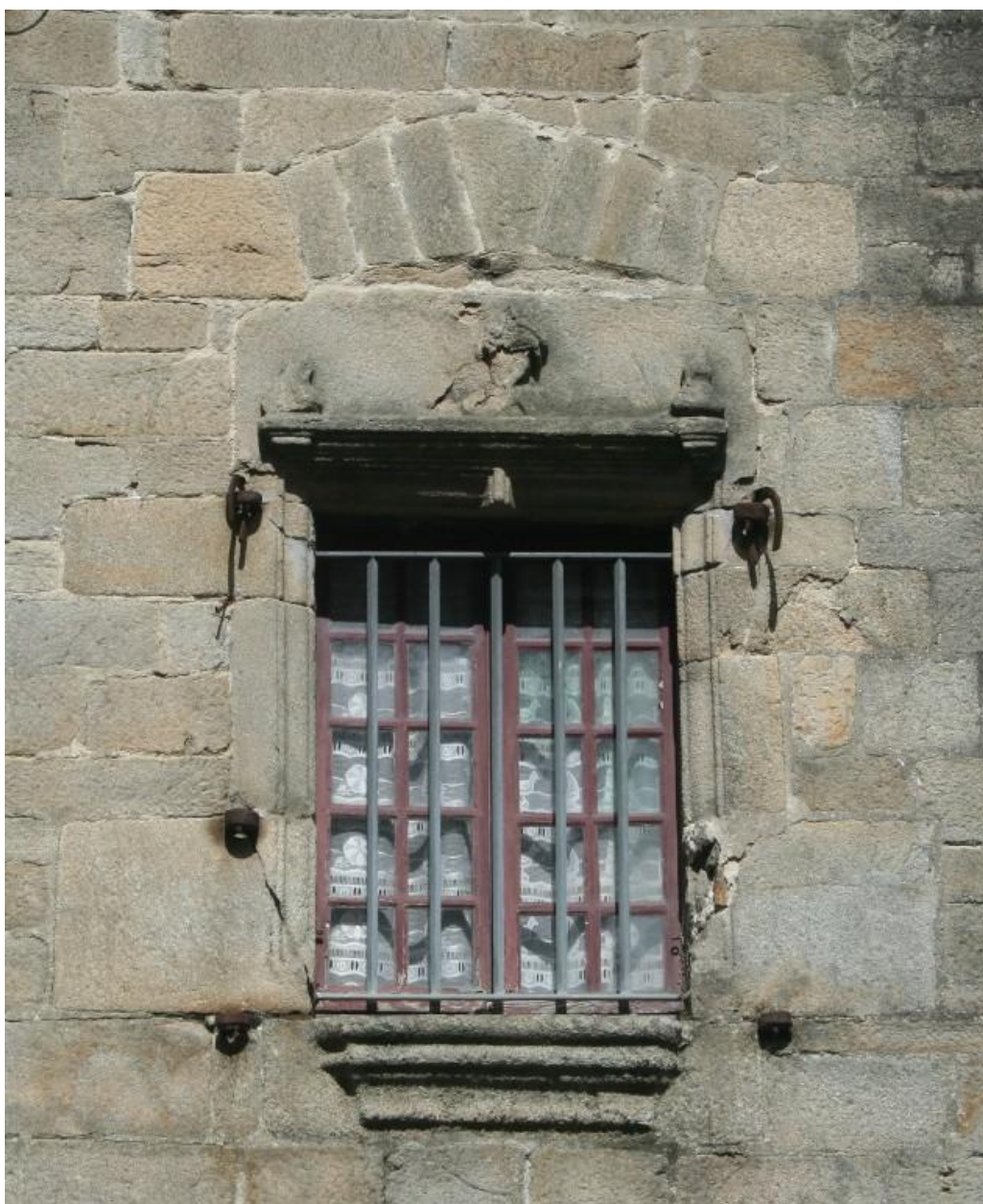
Détail de la fenêtre présente sur le mur gouttereau
