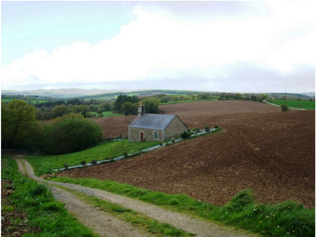
Poullaouen, chapelle Saint-Victor : vue de situation depuis le sud-est
