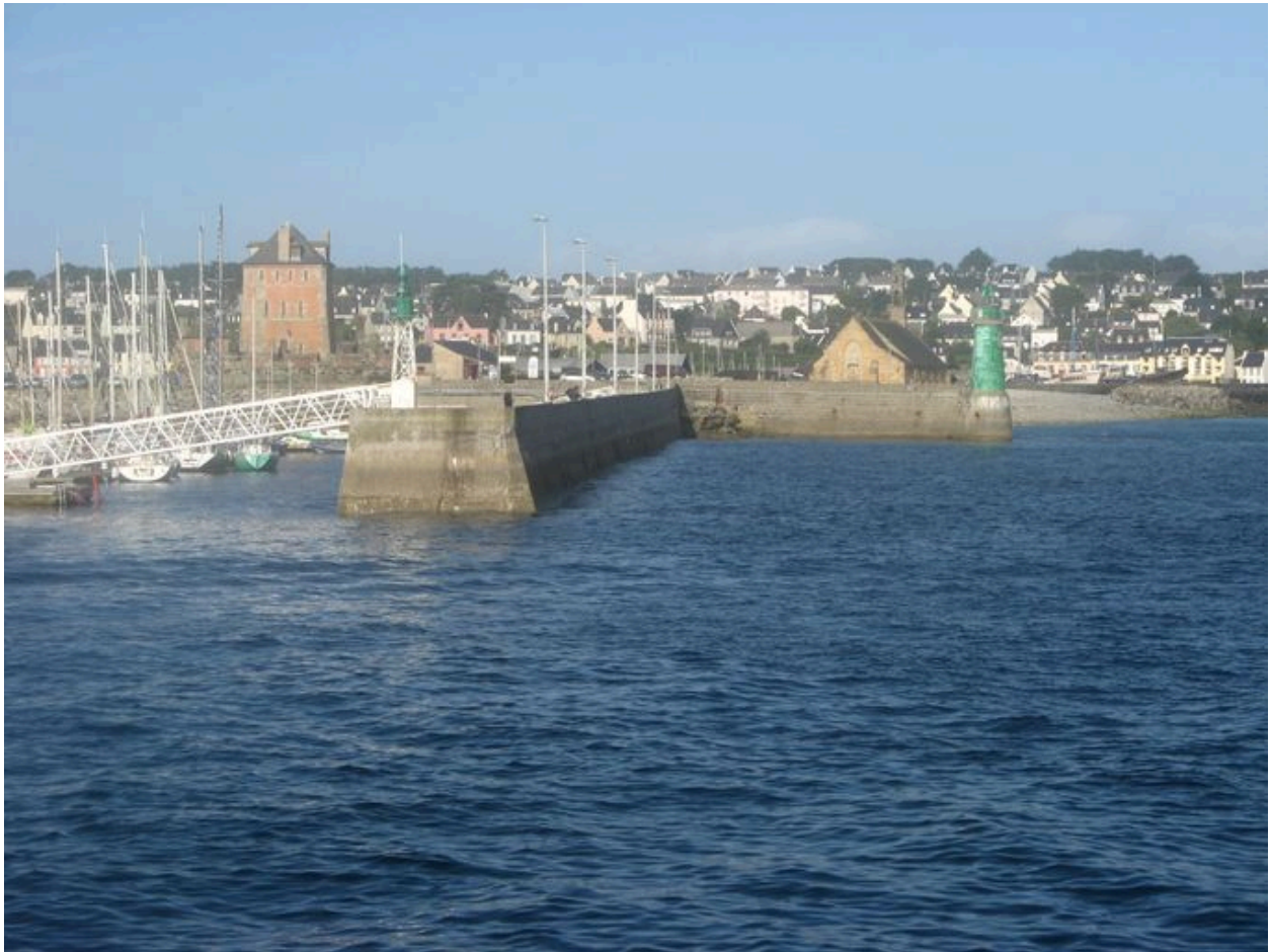
Vue générale du Môle Vert et de la digue
